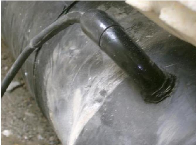
Abbildung 1-8: Auskabelung mit E-YY-J Kabel über PE Pfeife aus KMR-Mantelrohr
